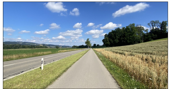
Veloinfrastruktur auf der Riedikerstrasse in Mönchaltorf nach dem Regelquerschnitt «T80 min ≥ 1.0 km» auf Staatsstrassen Eigene Darstellung
