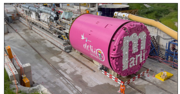
Tunnelbohrmaschine Gotthard-Thalwil (Bundesamt für Strassen ASTRA, 2022)
