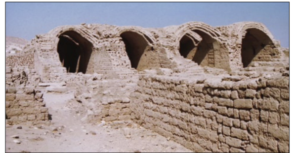
Lehmsteingewölbe nahe Luxor in Ägypten, ca. 1300 v. Chr. Schröder, Horst: Lehmbau, Springer Vieweg, 2019
