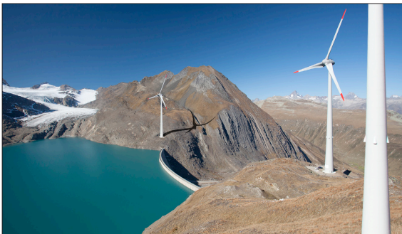
Windkraftanlage an einem durch die Nutzung von Wasserkraft vorbelasteten Standort
