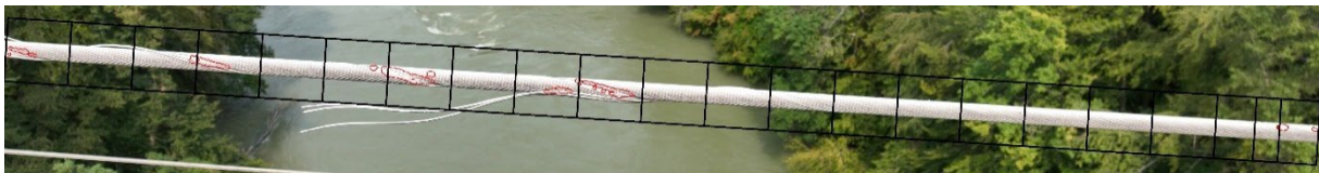
So sieht ein wartungsbedürftiges Leiterseil aus Sicht einer KI-Drohne aus. (Quelle: LINIA)
