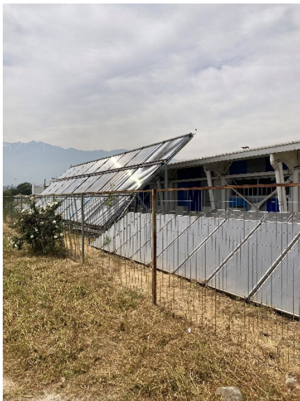
Abbildung 1: (links) Solarthermie-Anlage zur Beheizung des Campuspools
