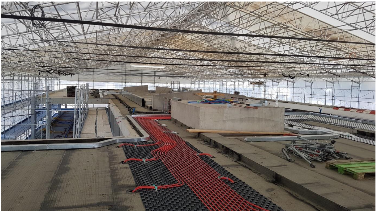
Abb. 7 Das Gebäude wurde im Winter mit einem Dach abgedeckt
