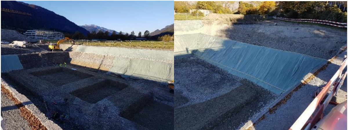
Abb. 1 Aushub Neubau Oblamatik AG
