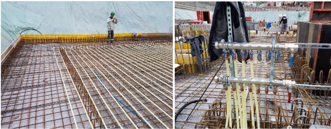
Abbildung 2: Verlegung der Leitungen für die Bodenplattenaktivierung.
