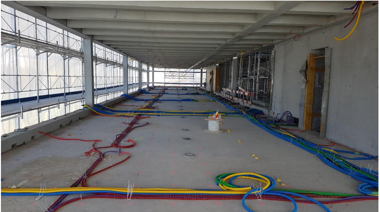
Abb. 6 Vorbereitung der Installationsschläuche
