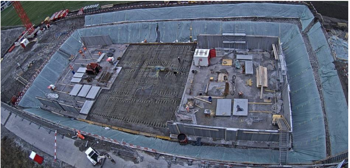
Abb. 4 Verlegung von Heizungsrohren im mittleren Teil der Fundamentplatte
