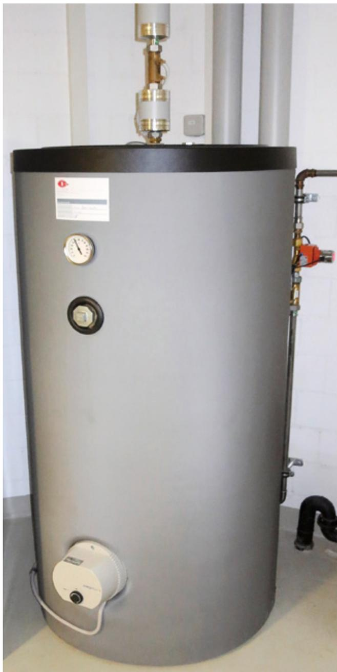
Abbildung 3: Wassererwärmer ohne Thermosiphon am Abgang der Trinkwasserleitung. Erkennbar ist auch die zweifach redundante Temperaturmessung am Speicherabgang.
