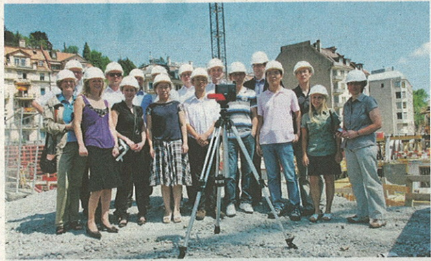
Die chinesischen Studenten auf der Baustelle der Fachhochschule. MVL
