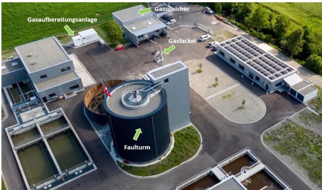
Abbildung 21: ARA Reinach mit Gasaufbereitungsanlage. Bildquelle: Müller, Christian; Oester, Ueli (2018): Biogasaufbereitungsanlage - Aufbereitung von  $40 \text{ Nm}^3/\text{h}$  Klärgas zu Reingas und Einspeisung ins 5 bar-Erdgasnetz. Hg. v. BFE Bundesamt für Energie, zuletzt geprüft am 20.05.2020
