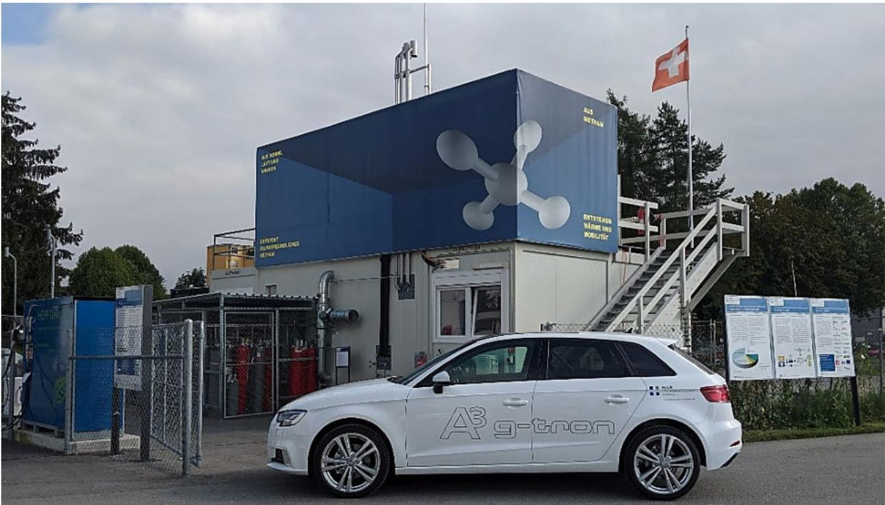
Abbildung 41: Aussenansicht der HEPP-Anlage. Im Hintergrund sind die Container, welche die Power-to-Methan-Anlage beinhalten. Im Vordergrund steht links die CNG-Tankstelle mit einem Gasfahrzeug.
