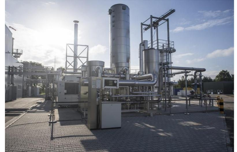
Power-to-Gas Anlage Werlte mit einer «Umwandlungsrate» Strom zu Gas von 54 %
