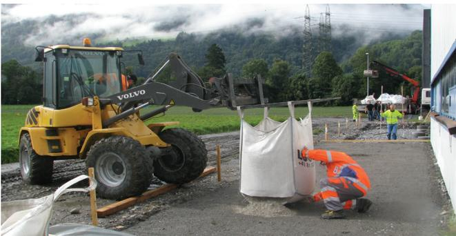
Abb. 3: Verteilung der neuen Bindemittelrezeptur auf einem Prüffeld im Rahmen des Grossversuchs.
