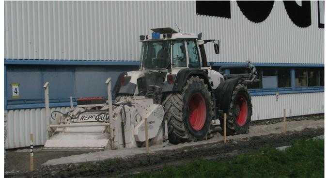
Abb. 4: Einarbeiten des Bindemittels in bindigen Boden mittels Bodenfräse
