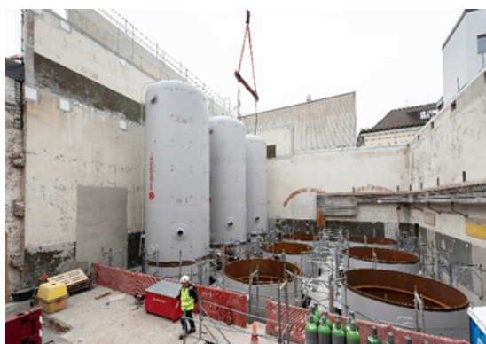
Bau des Wärmespeichers Dolder der IWB, 9 x 140 m 3 (Foto: Christian Flierl)
