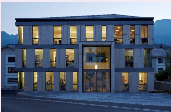
Abbildung 2: Gemeindeforum Vaz / Obervaz im Minergie-P Standard (Architekt: Michael Hartmann, Architekt und Energieberater, 7082 Vaz/Obervaz)
