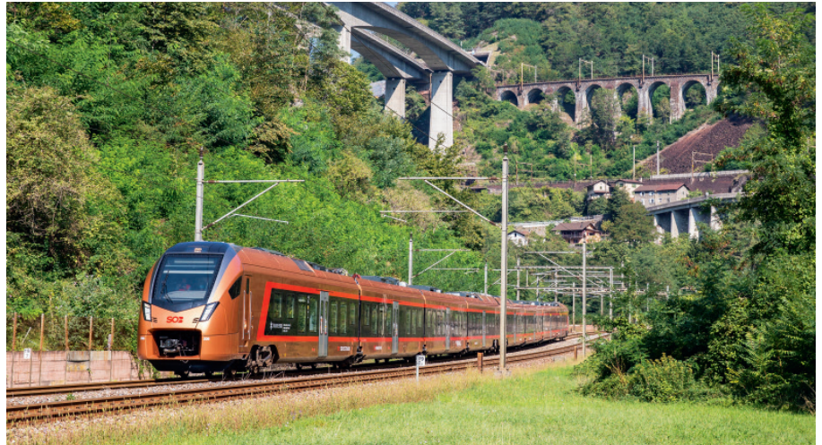
2: Mit dem Markteintritt in den Fernverkehr auf der Gotthard-Bergstrecke ab Basel/Zürich nach Locarno hat sich das Streckennetz der Südostbahn deutlich verlängert. Im Bild ein neuer Traverso-Flirt auf der Gotthard-Südrampe im Nordtessin
