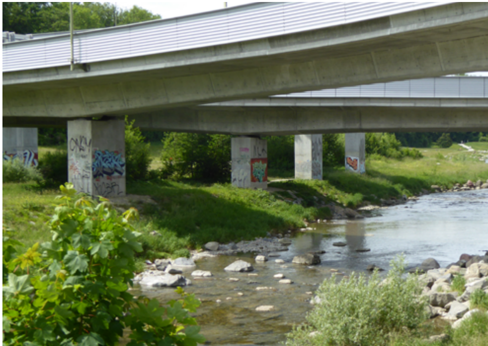
Abbildung 8: Naturnahe Ufer an Gewässern sind für Pflanzen und Tiere der Gewässer unentbehrlich. Auf der Abbildung die revitalisierte Sihl im Sihltal. Bildquelle: Dominik Siegrist
