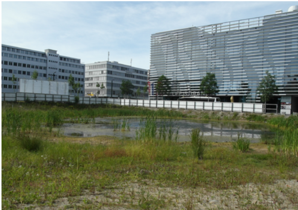
Abbildung 11: Temporäre Trittsteine auf einer Baustelle. Bildquelle: Jonas Brännhage
