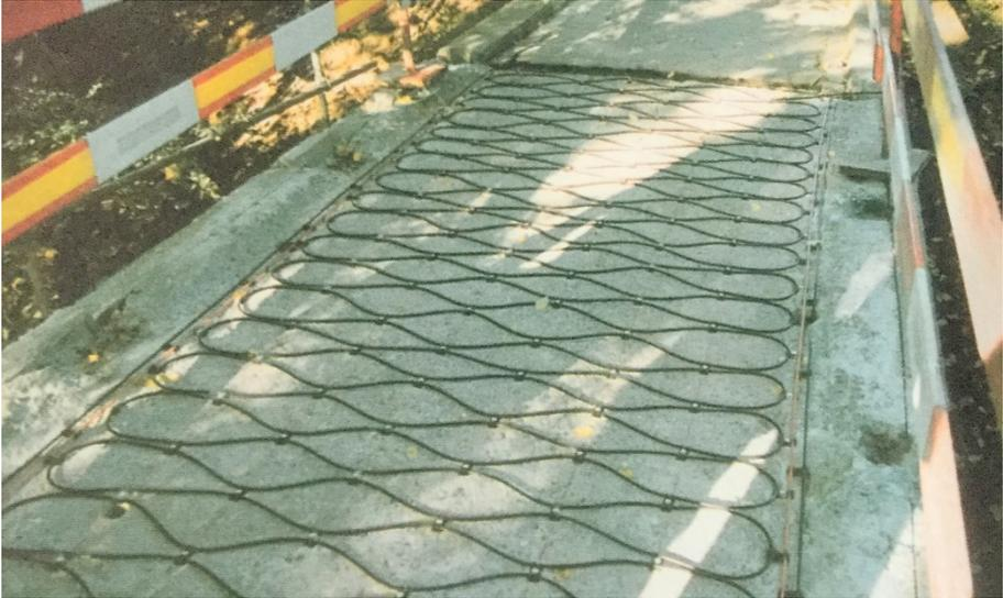
Bild 2: Elektrisch leitende Polymeranoden (Quelle: Raychem)
