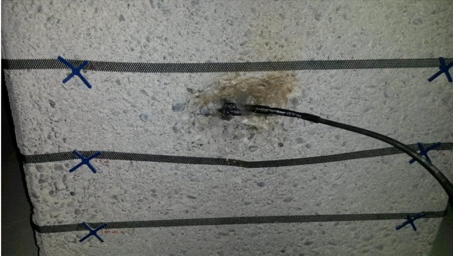
Bild 4: Aktivierte Titanbänder auf Stützensockel mit Bewehrungsanschluss
