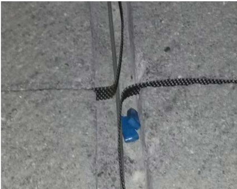
Bild 5: Aktiviertes Titanband in Betonschlitz eingelegt
