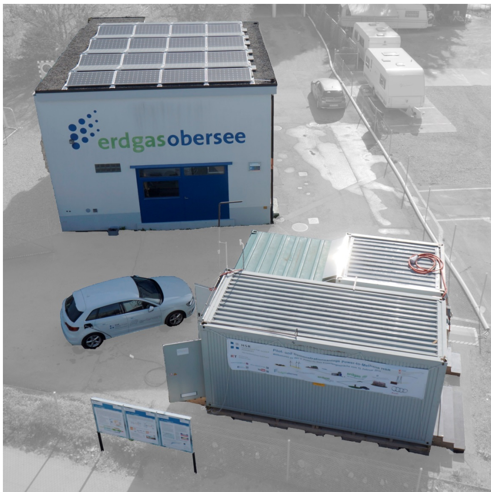
Bild der Pilot- und Demonstrationsanlage Power-to-Methane HSR, die seit Anfang 2015 am IET Institut für Energietechnik in Rapperswil in Betrieb ist.
