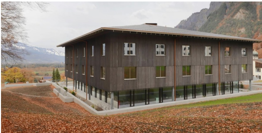
Abbildung 4: Beispiel Klinik Gut in Fläsch: Wurde in der blauen Gefahrenzone 2 gebaut mit Objektschutzmassnahmen (Mauer als Hochwasserschutz, Operationstrakt im OG) (Quelle: Präsentation Esther Casanova)
