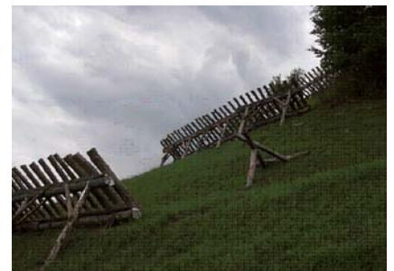
Lawinenverbauung oberhalb von Schiers GR
