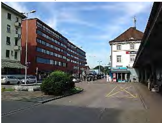
Abbildung 39: Bahnhofvorplatz und Bahnhofstrasse, Schlieren
