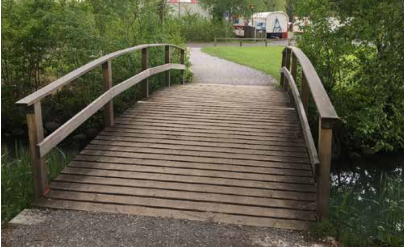
Abbildung 26: Brücke über den Aabach als Zugang zum Naturschutzgebiet Gross Allmeind
