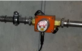
Bild 1 Links: Zweifach redundante Temperaturmessung im Medium. Rechts: Durchflussmessgerät
